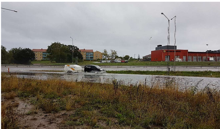
Foto 4 Översvämning avfart E22, i anslutning till planområdet. Foto från Kalmar Vatten
